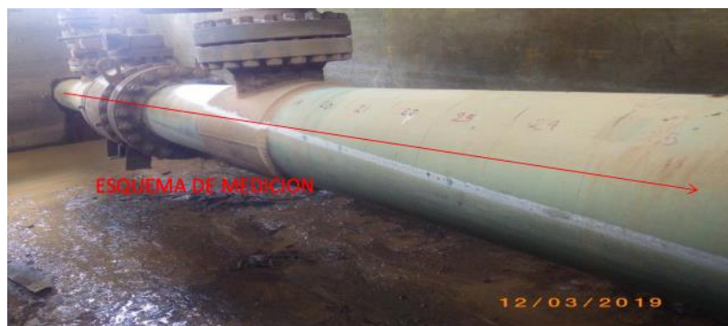
Fotografía 3. Area de inspección periódica en la unión de la plataforma Nenke, no se han detectado pérdidas de espesor por corrosión interna en esta sección, la inspección está limitada al uso de ultrasonido con haz recto.
