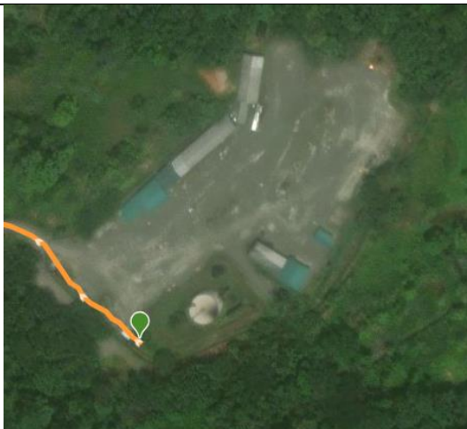
Figura 2. Inicio ducto 10in Plataforma ACAG
