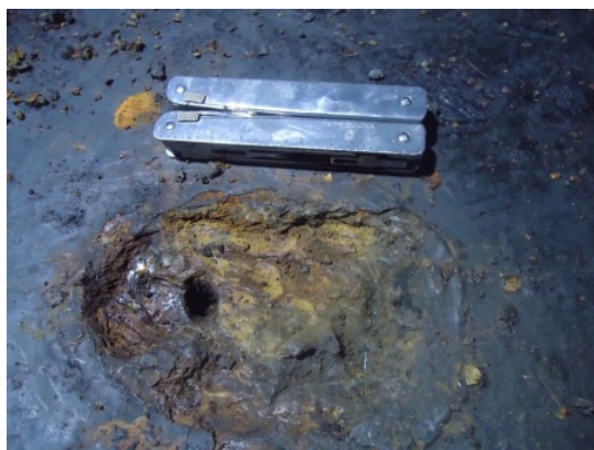
Fotografía Nro. 1: Perforación piso
